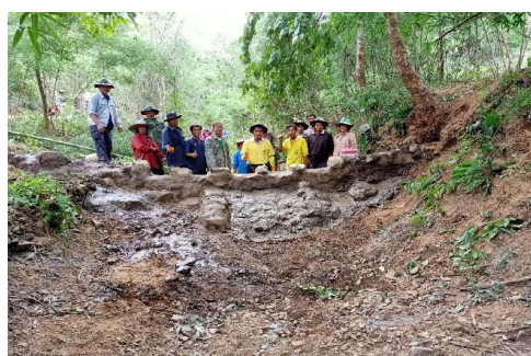
ภาพที่ 9 การสร้างฝายดักตะกอนในลำห้วยแม่ต๋ำ บ้านทุ่งผึ้ง
