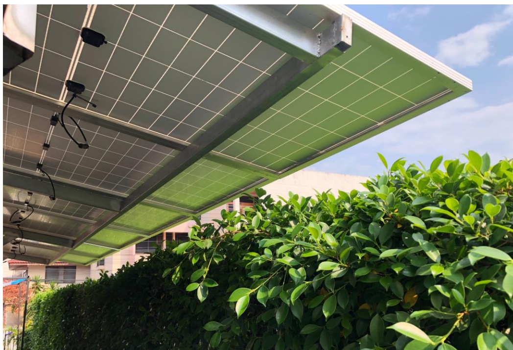
ภาพประกอบ 4 ประยุกต์การลดอุณหภูมิเปิดหลังแผง โดยอาศัยความชื้นจากต้นไม้
